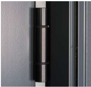
Sash & Jamb Hinge
